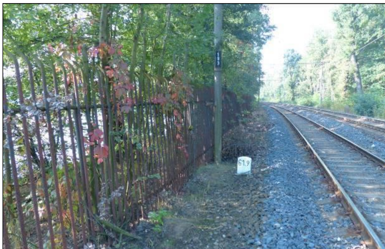
Foto 5. V úseku vedoucím okolím Kamencového jezera (km 61,9) na železniční těleso přesahují dřeviny a liány z okolních pozemků (loubinec popínavý).
